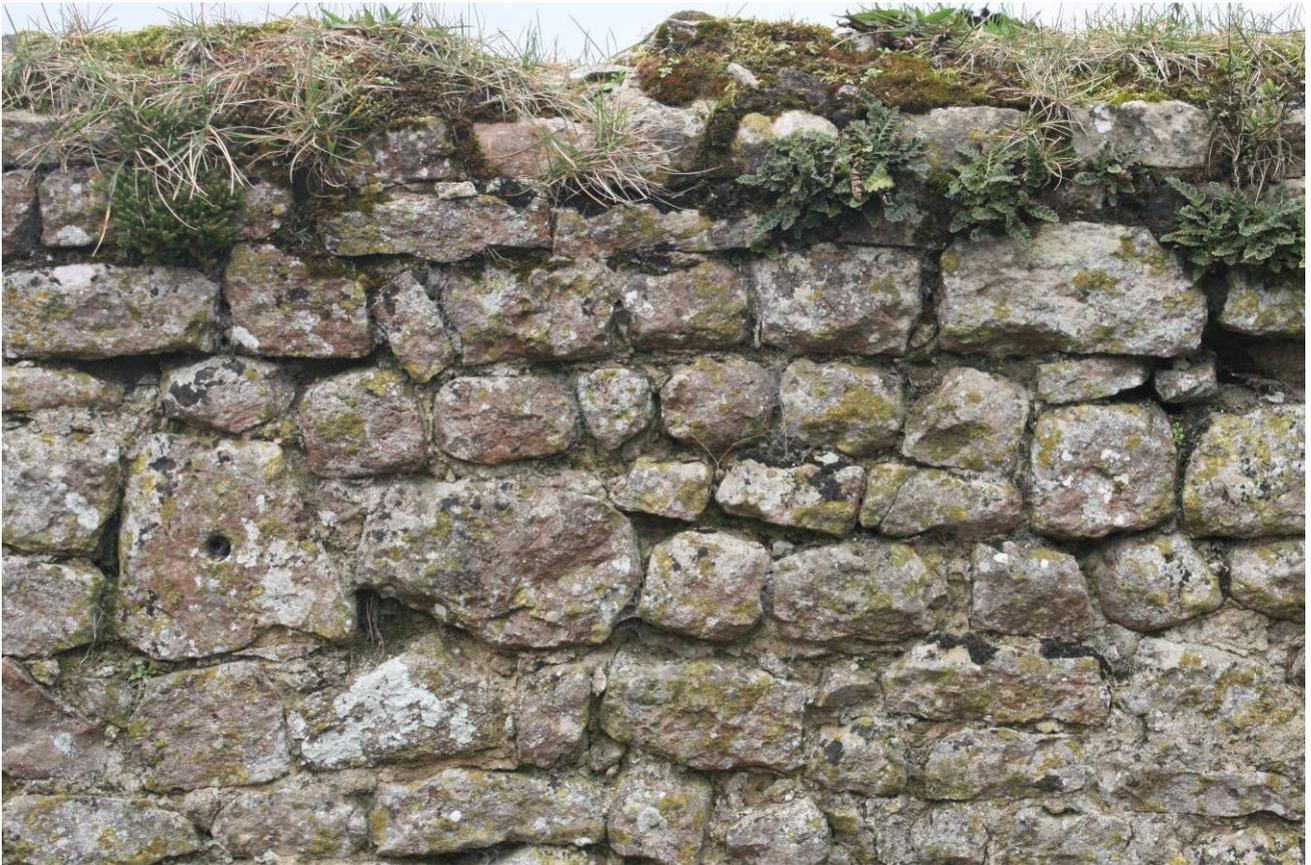
**Figure 54 : Petits appareils mis en oeuvre dans l'architecture de l'étable du Bas-Castelet**
