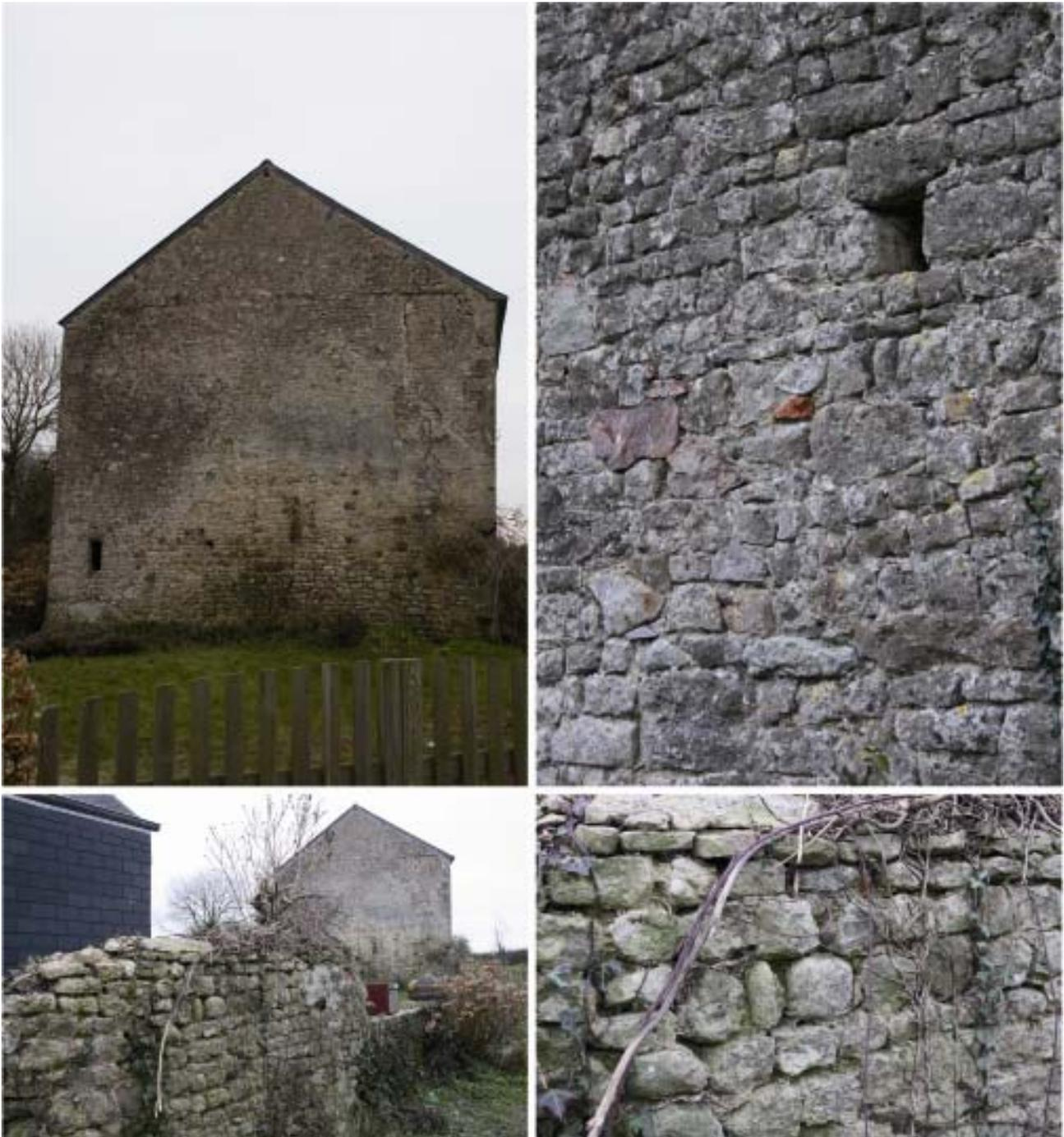
**Figure 45 : Réutilisation de pierres de construction d'origine gallo-romaine dans la maçonnerie des différents bâtiments de la Dingouvillierie**
