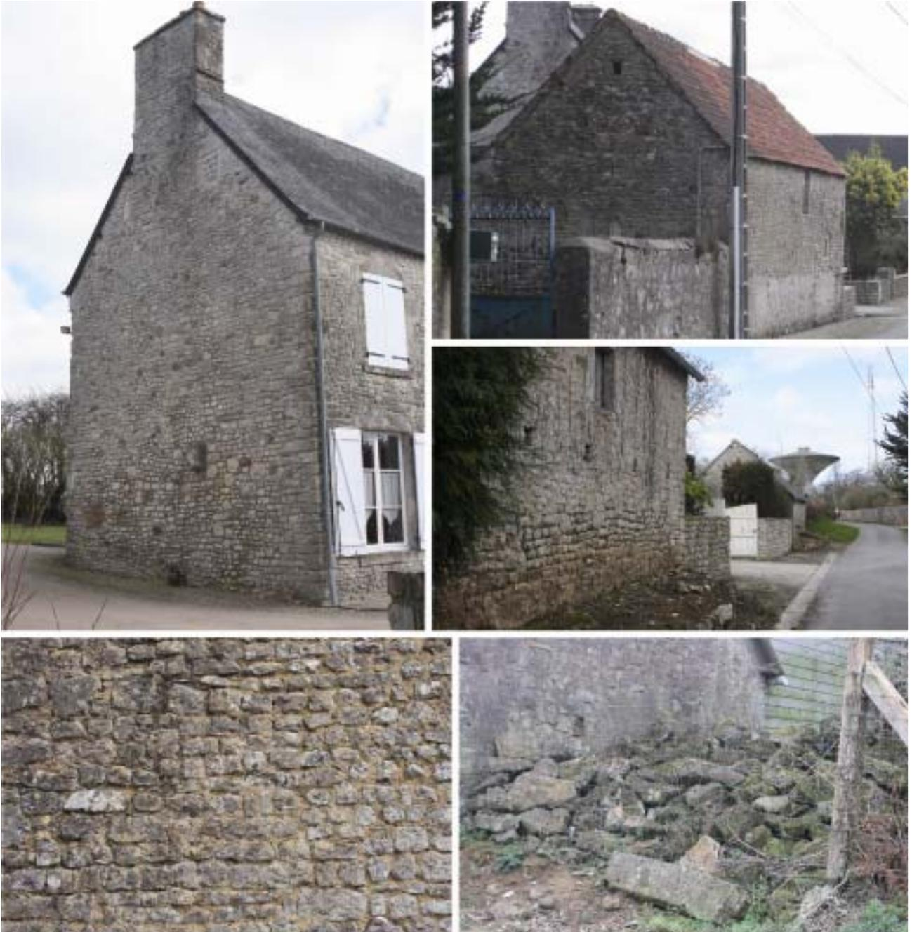
**Figure 66 : Exemples de pans de murs avec remploi de moellons cubiques**
