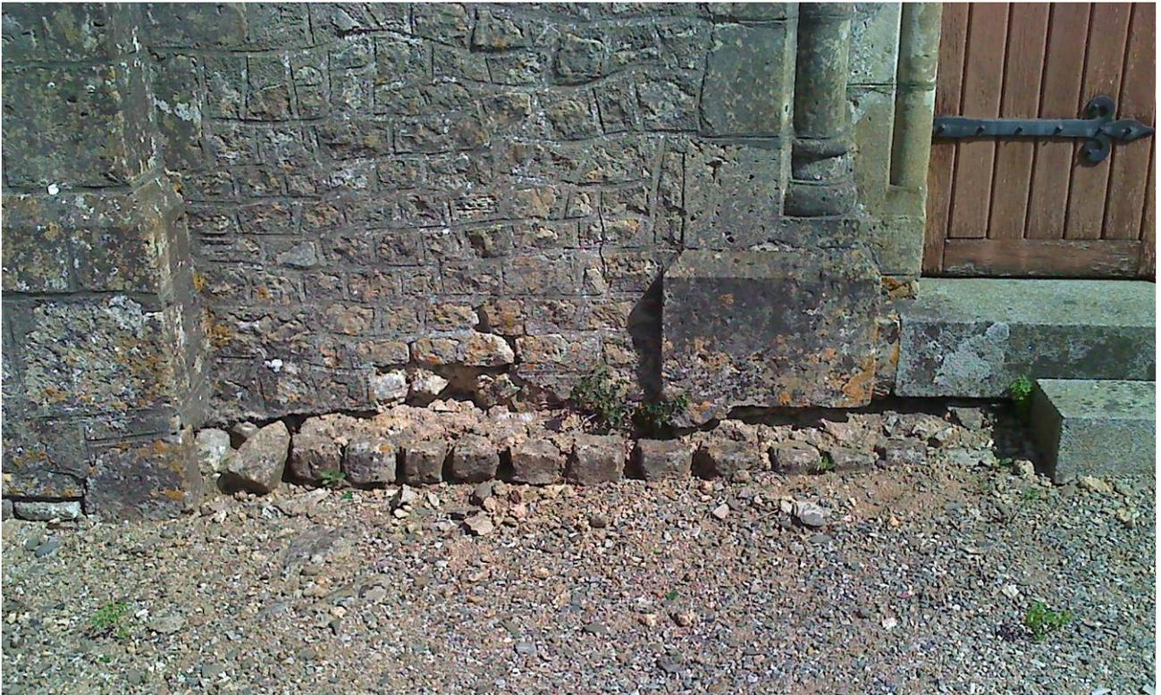
**Figure 58 : Maçonneries en petits appareils cubiques débordant de la façade de la chapelle**
