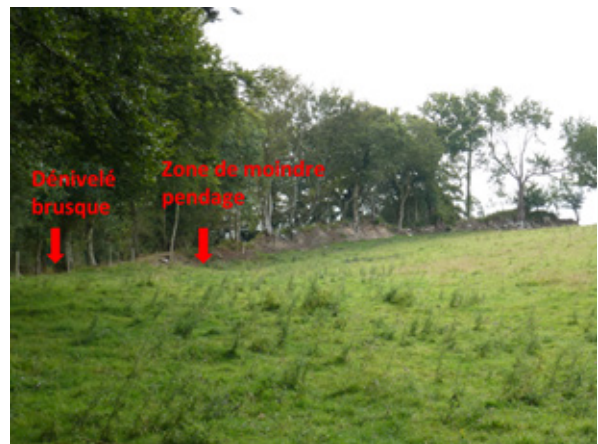
Figure 18 : la zone de moindre pendage avant la rupture de pente
