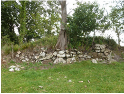
Figure 13 : parements de moellons
