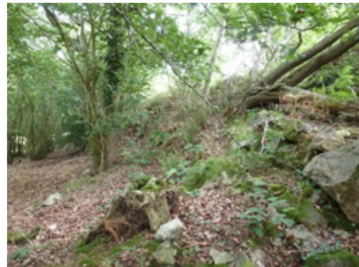
Figure 37 : les moellons sur la pente du rempart
