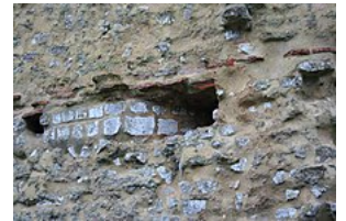
Aboutissement de la conduite de l'aqueduc.
