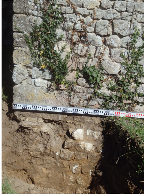
Figure 6 : Parement M02 sous l'angle sud-ouest de la chapelle sud du chœur (photo J. Deshayes)
