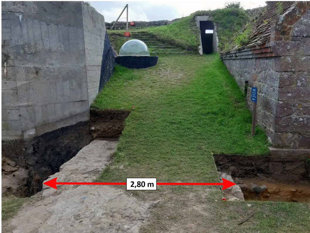
Fig. 11 : Base du mur de la tour centrale et largeur (Cliché : Dig Alderney)
