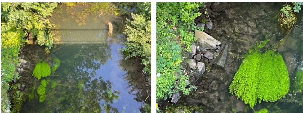
Fig. 9 et 10 : Aménagements en moellons au pied du pont actuel (photos prises depuis le pont)
