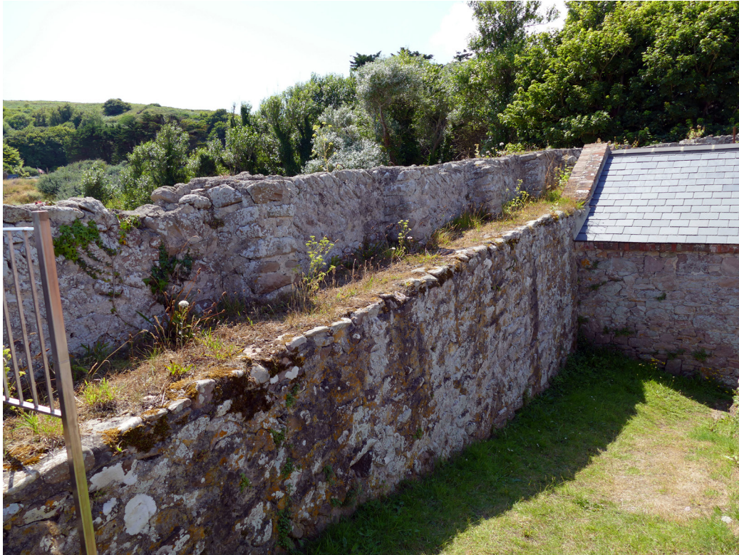
Fig. 13 : Mur sud – intérieur. Rempart et chemin de ronde avec une rangée complète de pilastres (à un rang près). (Cliché Ch. Brémont)
