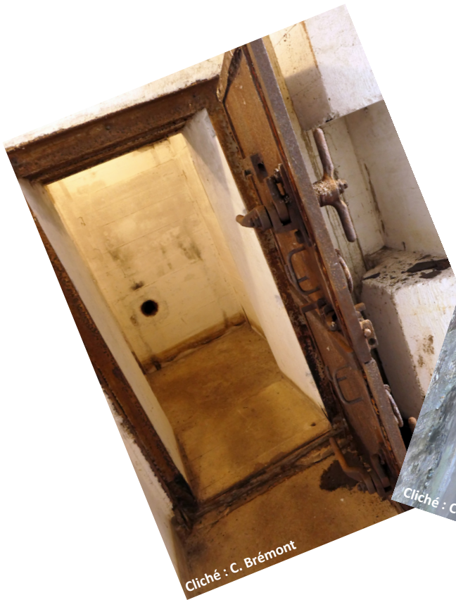
Intérieur du bunker.
