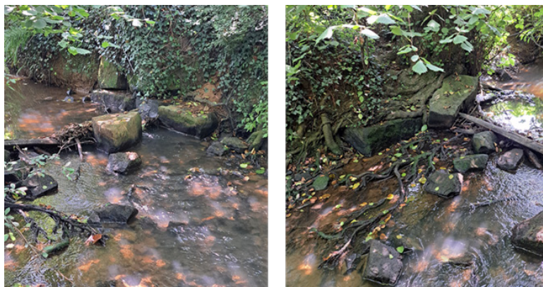
Fig. 27 et 28 : Aménagements de gros moellons de part et d'autre de la rivière
