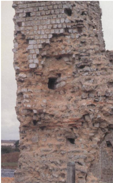
Raccordement de l'aqueduc aux thermes matérialisé par les arrachements de maçonnerie autour du conduit contenant probablement une tuyauterie de plomb. Photo © Th. Lepert.
