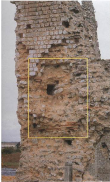
Arrachement témoignant du raccordement de l'aqueduc au thermes. (T. Lepert.)
