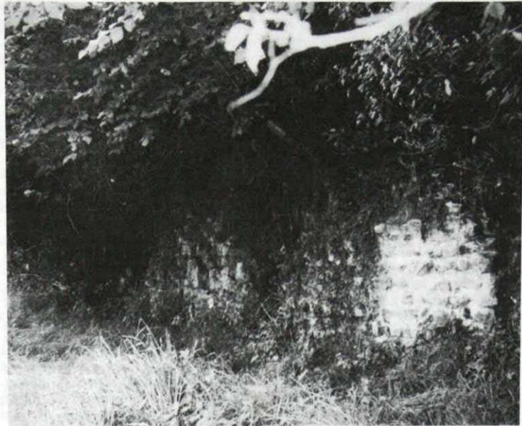
Le grand mur gallo-romain. L'arrachement des parements laisse apercevoir le mode de construction en couches de moellons posés horizontalement en «hérisson», puis recouverts par une épaisse couche de mortier de chaux (G.S.).
