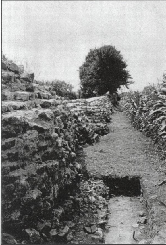
Le mur du Castrum (photo C. Butel)
