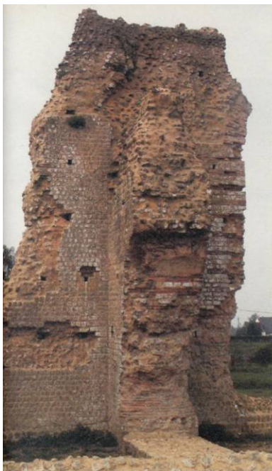
Ci-dessus. Refend entre le tepidarium T1 et le caldarium C montrant le passage de chaleur entre les hypocaustes sous la porte en 2004. Photo © E. Follain.
