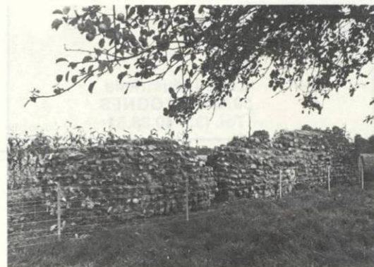
Les détails d'un mur dégagé en juillet 1982. Les pierres sont disposées en lits noyés dans une épaisse couche de mortier. Il ne reste rien des pierres de petit appareil qui formaient le parement vertical.
