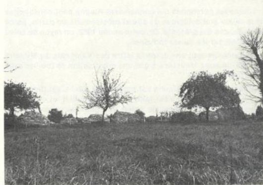
Vue d'ensemble du mur gallo-romain dégagé en juillet 1982.
