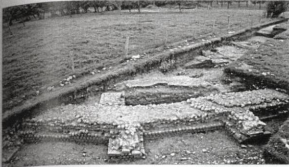
Fig. 9 - Mur extérieur du théâtre de Vieux, sondages 2001 (cliché E. Delaval).
